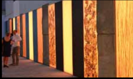
Die Lichtwand besteht aus 18 Lightpanels, teilweise mit Dekoroberfläche, und spritzwasserfest ausgerüstet.
